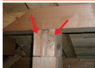
寸不足材で付け足しをして施工
