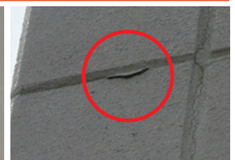
外壁材の割れ、欠損
